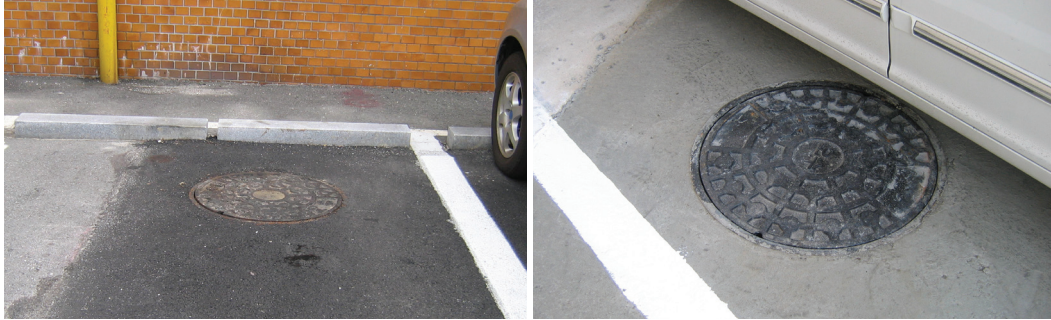
맨홀 설치 광경(농대 3호관 뒤)
