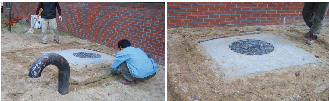
맨홀 설치 광경 (약대)
